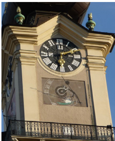
Fig. 2 Torre del siglo XVI, en el edificio de la sede del parlamento en Linz, Austria. Puede apreciarse el casco barroco y en el cuerpo de la torre un reloj mecánico y un reloj solar que se repiten en cada una de sus fachadas. Los relojes solares con técnica de esgrafiado, fueron diseñados por Fritz Fröhlich, un pintor austriaco contemporáneo. Foto: Siegfried Rasper.
