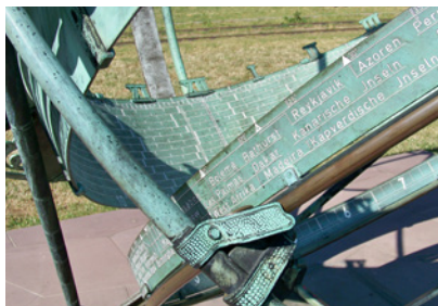
Fig. 6 Reloj solar ecuatorial de 3.4 metros de diámetro, instalado en Frankfurt, Alemania en 1951 (Loske 1999). Sus carátulas marcan la hora solar de Frankfurt y la hora solar del meridiano 15° E , que rige la hora legal en Alemania. También es posible determinar la fecha, la hora solar , la hora solar media y la hora legal de 200 ciudades alrededor del mundo. Esto mismo puede lograrse para cualquier sitio sobre la Tierra, siempre y cuando se conozcan sus coordenadas geográficas. Diseño: Lothar M. Loske.
